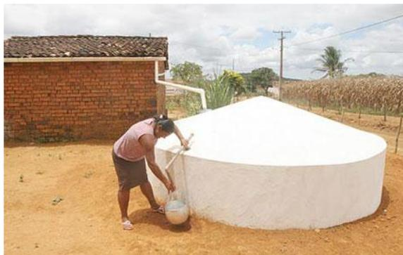
*Figura 15.* Captación y canalización de agua de lluvia, para máximo aprovechamiento y reserva en cisternas
