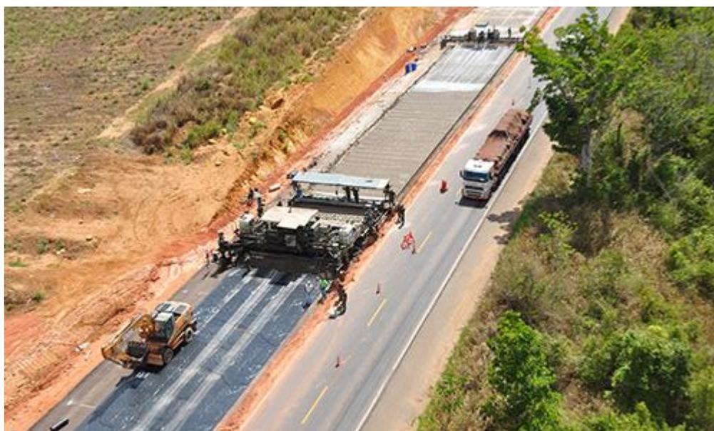
*Figura 9.* Desde 2005 hasta 2011, duplicación y restauración de 142,5 km del denominado Corredor Nordeste de la BR-101 / NE con pavimento rígido
